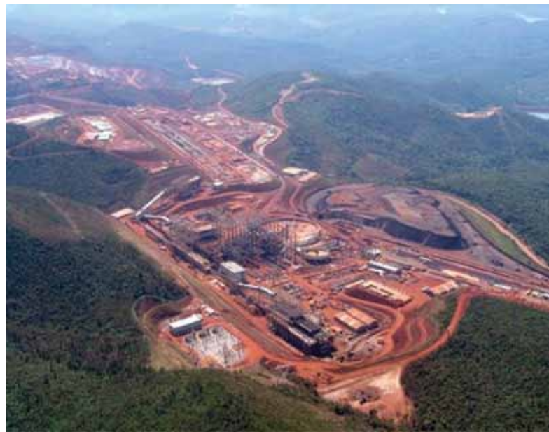
Vista do Complexo de Brucutu, em Minas Gerais, é considerada a maior usina de ferro do mundo
