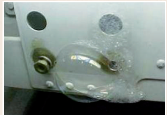
Figura 10 - Formação de bolhas na localização de vazamento em um tanque
