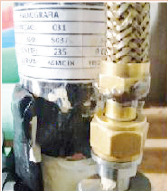
Figura 6 – Montagem de filme de gravação em solda de tubulação de O2
