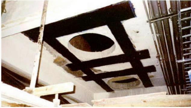
Figura 22 – Fábrica de Laticínios Itambé em Sete lagoas MG, onde foi executado um reforço ao redor dos furos na laje.
