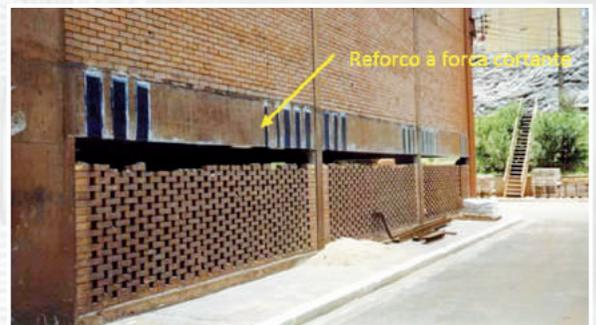
Figura 20 – Reforço à flexão e à força cortante de viga externa do Edifício da Alcan Alumino do Brasil em Ouro Preto. ([http://www.cesec.ufpr.br/pet/titulo/biblioteca/seminarios/arquivo\\_seminarios/construcao\\_civil/reforco\\_estrutural\\_com\\_fibras\\_de\\_carbono.pdf](http://www.cesec.ufpr.br/pet/titulo/biblioteca/seminarios/arquivo_seminarios/construcao_civil/reforco_estrutural_com_fibras_de_carbono.pdf), visitado em 20/09/08).
