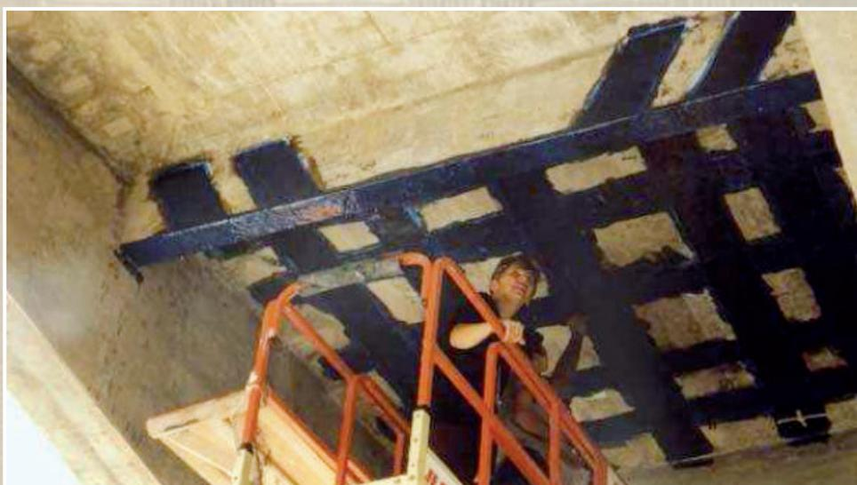
Figura 1 – Laje e viga reforçada no viaduto de Santa Tereza.
