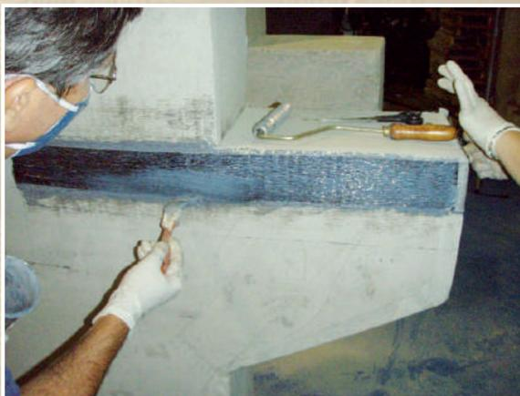
**Figura 16 - Aplicação de mais uma demão de resina epóxica.**
