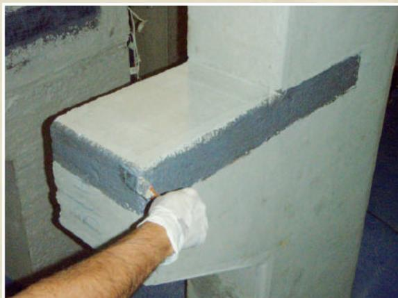
**Figura 13 - Realizar a mistura da resina epóxica na proporção de 1:4, com posterior aplicação na superfície do concreto.**
