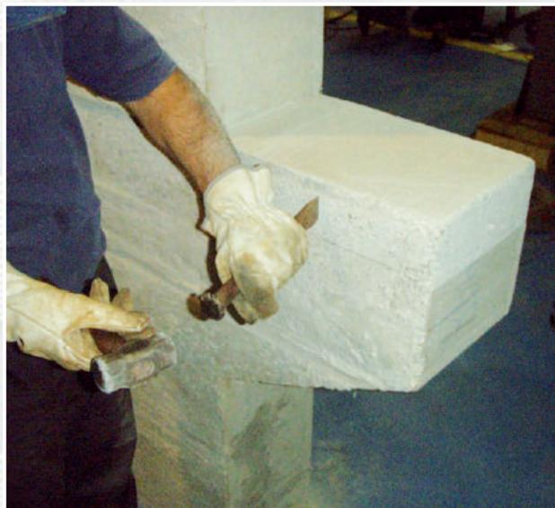
Figura 10 - Regularização da superfície com o uso de uma talhadeira.
