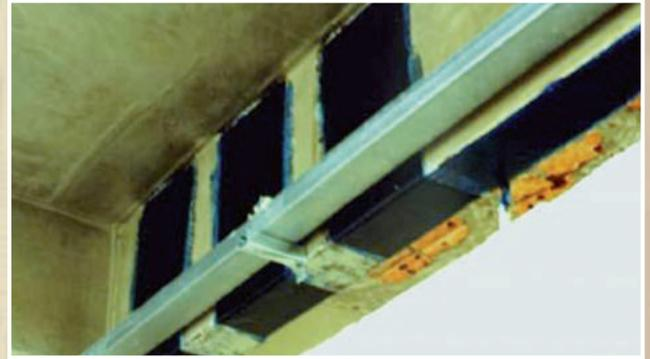
Figura 23 – Reforço da viga à flexão e à força cortante na Fundação Mineira de Educação e Cultura – FUMEC.
