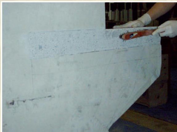
**Figura 11 - Utilização de escova de aço em toda superfície de aplicação do CFC. Arredondamento das quinas e lixamento da superfície com o uso de uma esmerilhadeira, a fim de obter superfície plana.**
