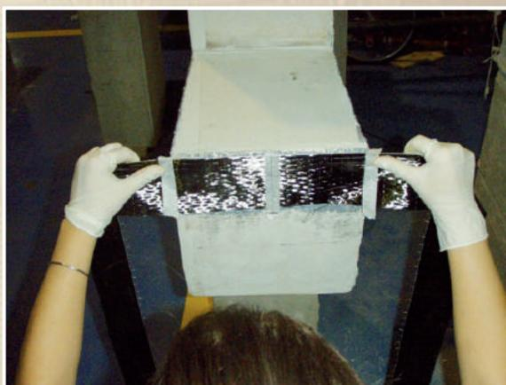
**Figura 15 - Colocação do CFC na superfície.**
