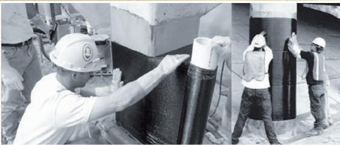
Figura 18 – Reforço de pilares retangulares e de colunas. ([http://media.wiley.com/product\\_data/excerpt/61/04716812/0471681261.pdf](http://media.wiley.com/product_data/excerpt/61/04716812/0471681261.pdf), visitado em 20/09/08).
