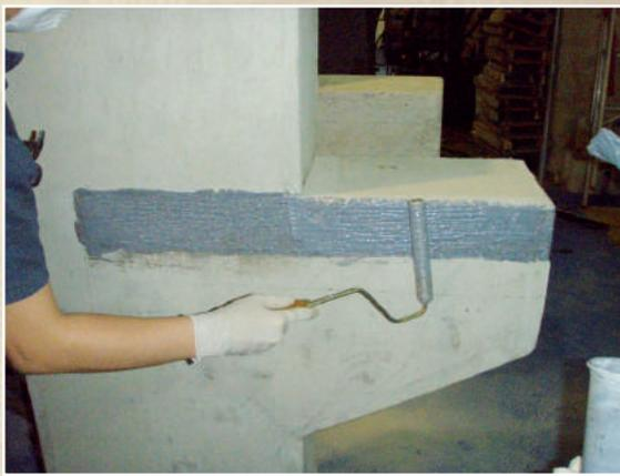
**Figura 14 - Utilização do rolo para obtenção de rugosidade para aderência do CFC.**
