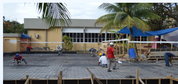
Foto: Construção do Prédio Anexo.
