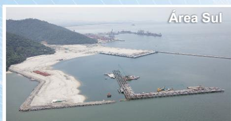
As obras de construção do Estaleiro e da Base Naval na Área Sul continuam se desenvolvendo em ritmo acelerado. As atividades técnicas relativas ao enrocamento, infraestrutura e aterro marítimo estão bastante adiantadas, o que permitiu o início das atividades de construção do prédio principal das oficinas, cujas fundações
