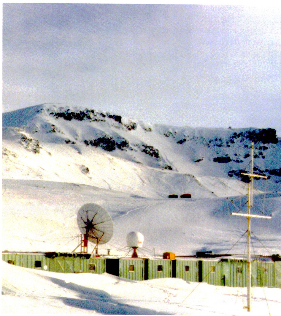
Antenas de comunicação no teto da EACF
