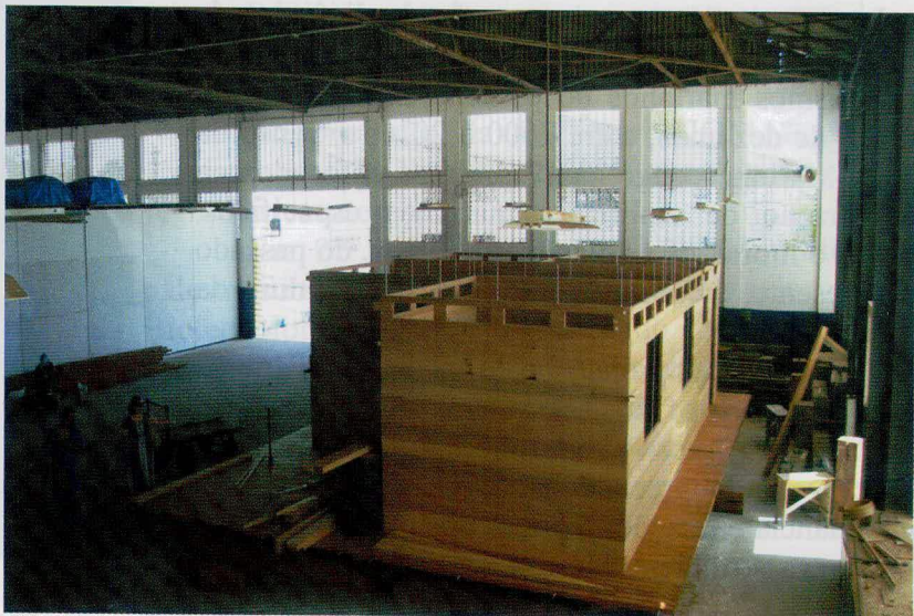
Obras de pré-montagem da Estação Científica na BNN
