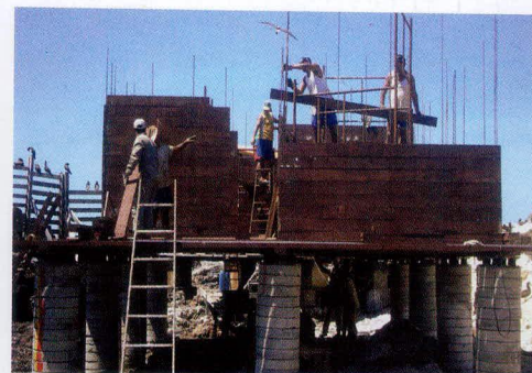
Figura 4 - Montagem do sistema viga-laje.
