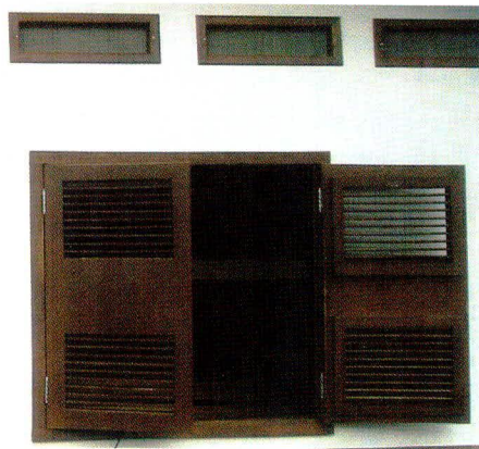
Figura 7 - Detalhe da ventilação superior e das janelas com venezianas móveis.
