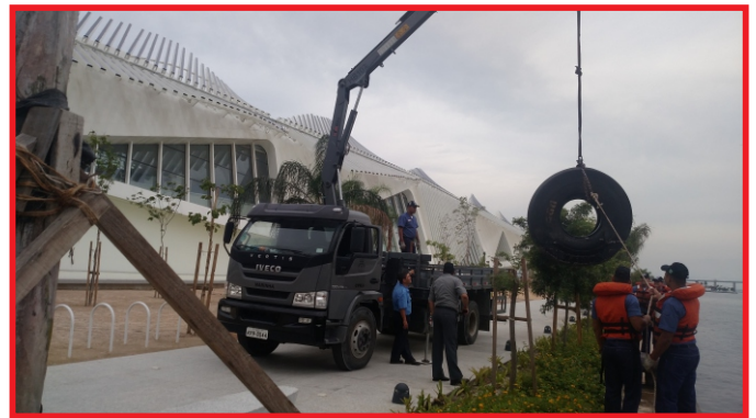
Militares do Grupamento retirando pneu-defesa do Pier Mauá
